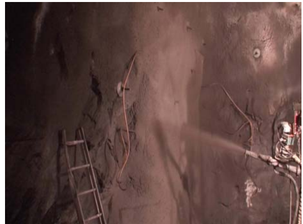
Verkon ankkurointi ruiskubetonilla
