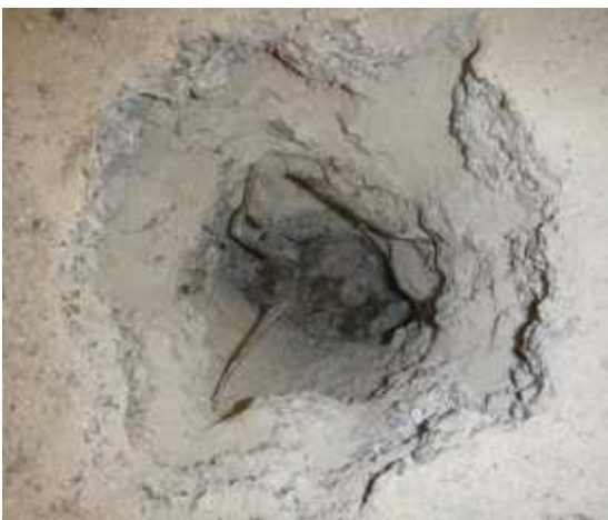
Kuva 1. Luokkatilan 2 rakenneavaus alapohjaan
